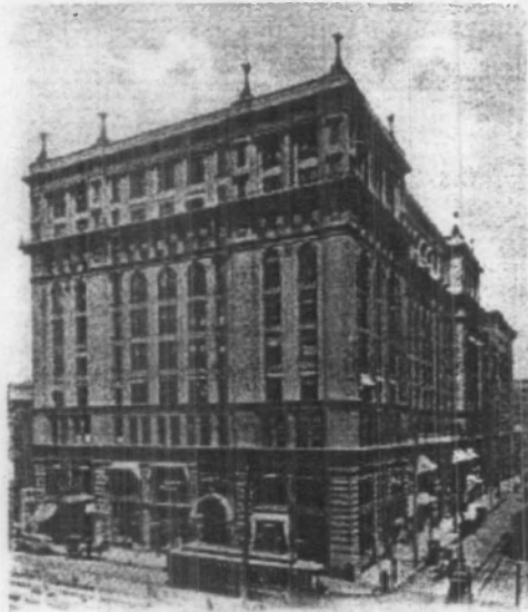
Century Building, St. Louis, U. S. A.
